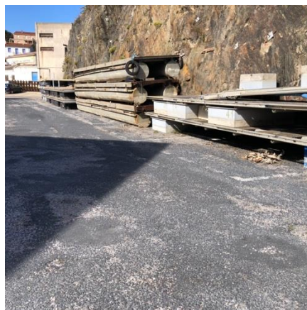
Une surface enrobée en affaissement qui ne peut pas porter de charges
